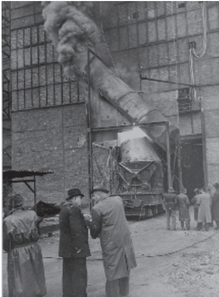
Dopo il primo test del processo LD avvenuto il 25 giugno 1949 in una siviera modificata da 2 tonnellate, Theodor Suess, direttore tecnico, assiste qui a un test con un "convertitore di prova" da 15 tonnellate. Ottobre 1949. (Associazione "Geschichteclub Stahl")
