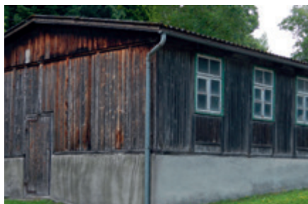
Tento dodnes dochovaný obytný barák v Kremsmünsteru obývali v éře nacismu mimo jiné dělníci nuceně nasazení v HGW a váleční zajatci. Řadu těchto baráků obývali po roce 1945 vysídlení z oblastí Jablonce nad Nisou, postupně došlo k přebudování staveb na rodinné domy. (Dokumentální centrum voestalpine AG)
