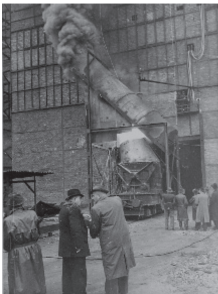
Poté, co byl LD proces poprvé vyzkoušen 25. června 1949 v přestavěné 2tunové lící pánvi, sleduje technický ředitel Theodor Suess pokus s 15tunovým „pokusným konvertorem“. Říjen 1945 (Geschichteclub Stahl)
