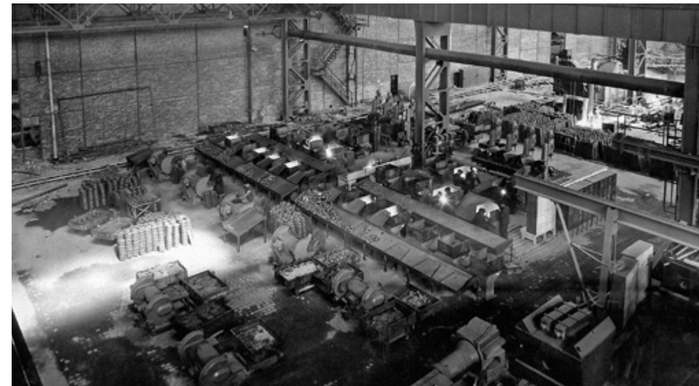
Innenansicht Werkshalle Gesenkschmiede, 1943
