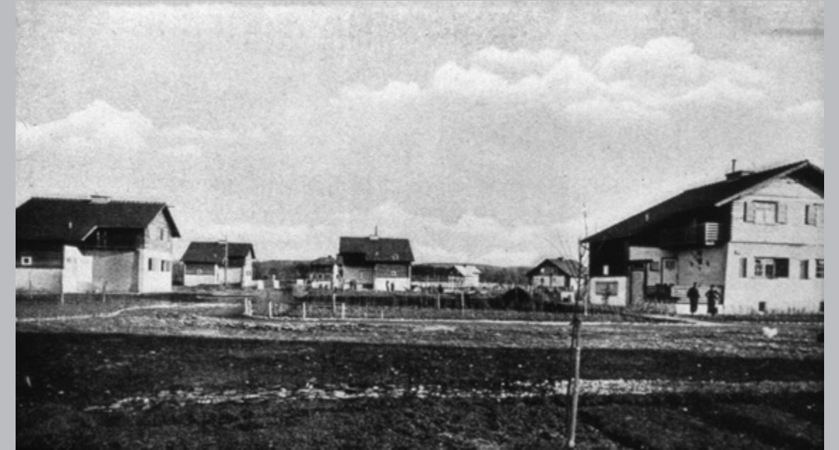
Ein Teil der neu errichteten Siedlung an der Sternbauerstraße, 1936
