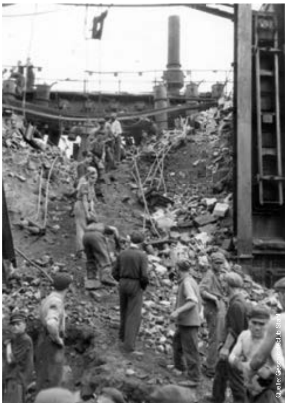
Aufräumarbeiten im Bereich der beschädigten Batterie 1 der Kokerei (25. Juli 1944)
