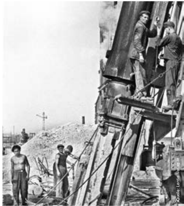
Rahmen der Spundwände für das Werkshafenbecken (1940) à Bild an der Hörstation „Nationalitäten der Zwangsarbeiter“
