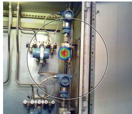
Undichte Verschraubung
