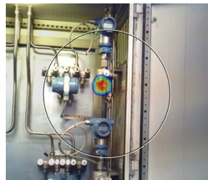
Undichte Verschraubung
