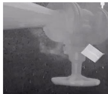
Undichter Schieber
