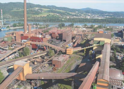
Förderanlagen bei Sinter- und Hochofenanlage
