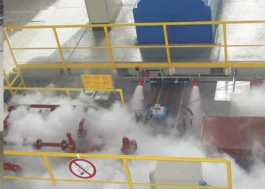
Gaslöschanlage
