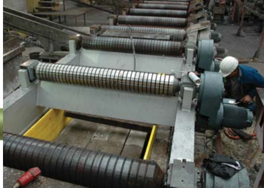
Erneuerung Auslaufrollgang CC4
