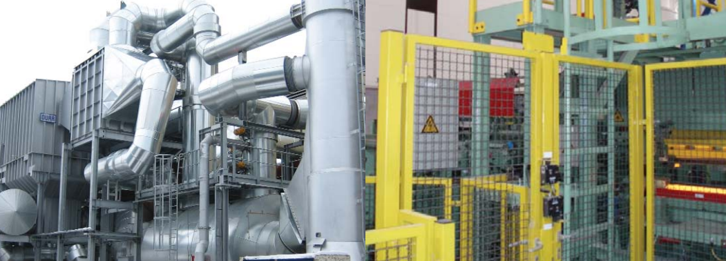
Abluftreinigung - Bandbeschichtung 1
