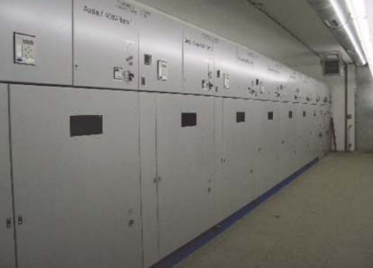
Niederspannungsanlage Kraftwerk
