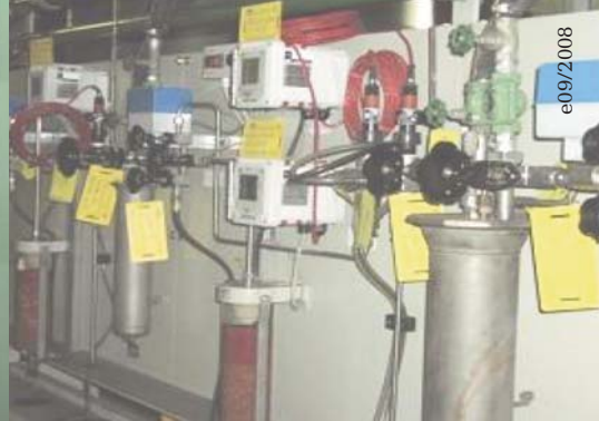
Kesselanalytik Kraftwerk
