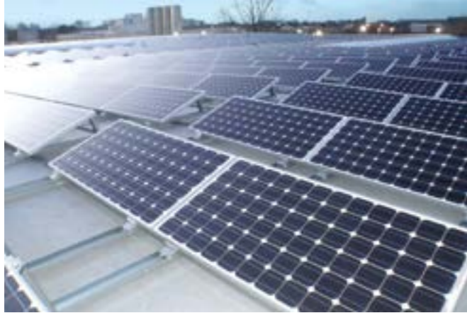
AVEC ANCRAGE PAR COLLAGE
