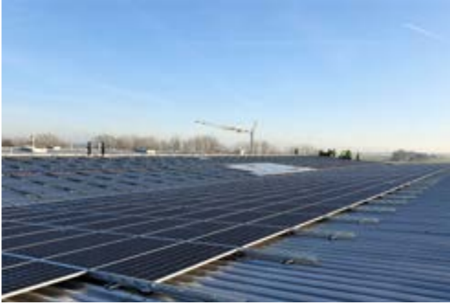
PANNEAUX SOLAIRE DIRECTEMENT FIXÉS SUR LES PANNES
