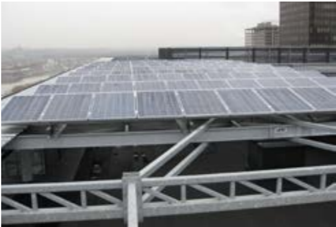
PANNEAUX SOLAIRE DIRECTEMENT FIXÉS SUR LES PANNES
