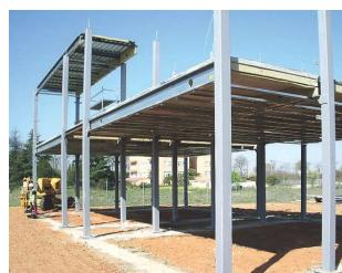
Pour construire rapidement, à moindres coûts et indépendamment des conditions météorologiques, la solution peut être la préfabrication de modules 2D.
