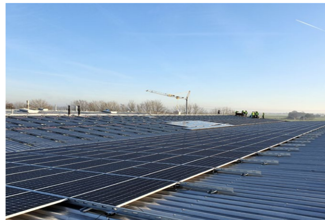
SOLAR-MODULE MIT DIREKTER BEFESTIGUNG AUF DEN DACHPFETTEN
