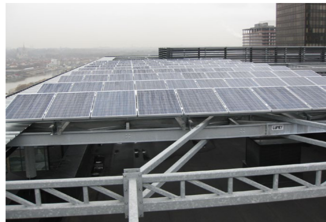
SOLAR-MODULE MIT DIREKTER BEFESTIGUNG AUF DEN DACHPFETTEN
