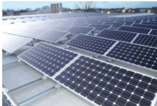
**SOLAR-MODULE MIT DIREKTER BEFESTIGUNG
