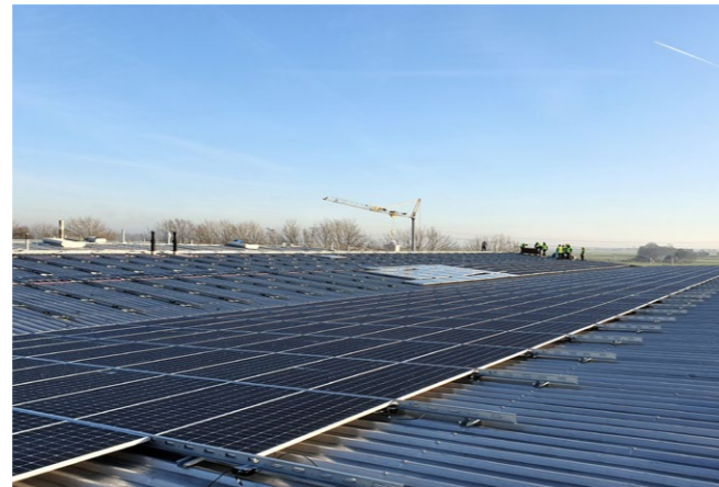
ZONNEPANELEN DIRECT OP DAKGORDINGEN BEVESTIGD
