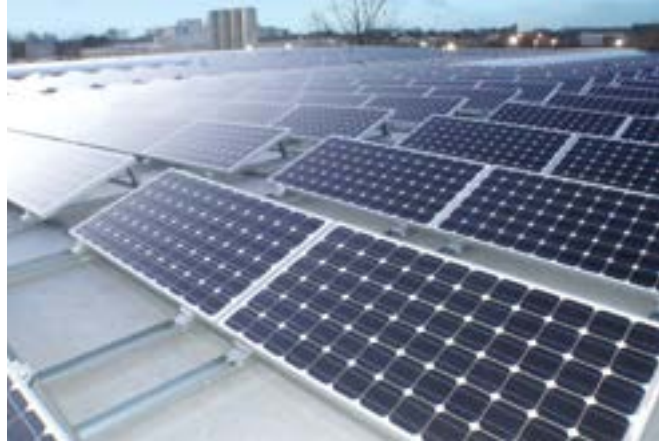
VERANKERD VIA VERLIJMING
