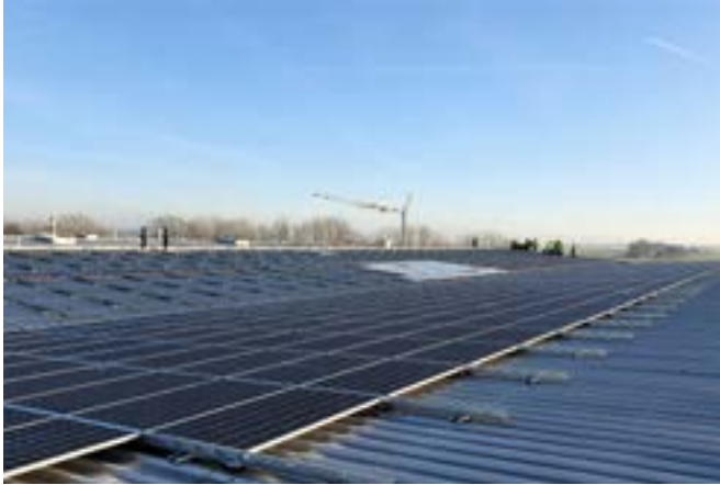
ZONNEPANELEN DIRECT OP DAKGORDINGEN BEVESTIGD
