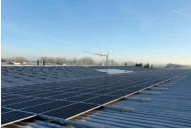
ZONNEPANELEN DIRECT OP DAKGORDINGEN BEVESTIGD
