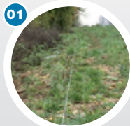
01 Posicionamiento del cable de alineación
