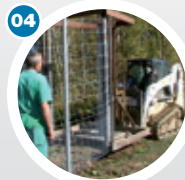
04 Colocación y conexión eléctrica de la rejilla
