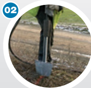
02 Colocación de las bases con un martillo neumático
