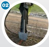
Versenkung der Sockel mit einem einfachen Drucklufthammer
