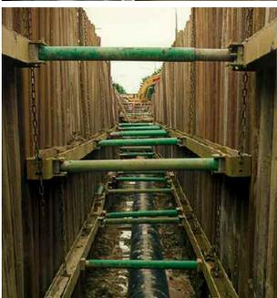
Les profils de blindage peuvent être mis en place par toutes les techniques modernes de battage, de vibrations électriques ou hydrauliques avant l'excavation ou au fur et à mesure grâce à un guide placé dans la fouille préliminaire.
