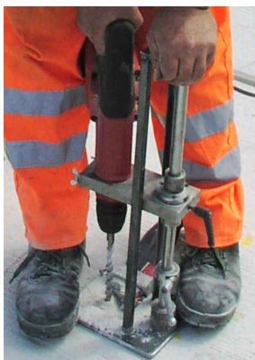
Bohrloch erstellen
