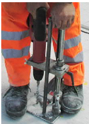
Bohrloch erstellen
