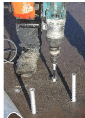
Asphaltschraube eindrehen
