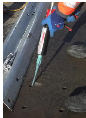
Verbundmasse einbringen
