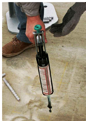
Verbundmasse einbringen
