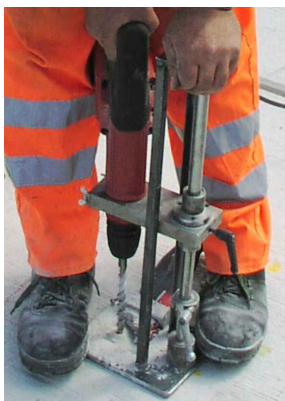
Bohrloch erstellen
