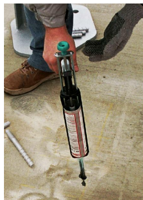
Verbundmasse einbringen
