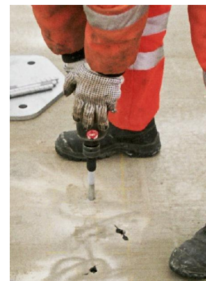
Betonschraube eindrehen
