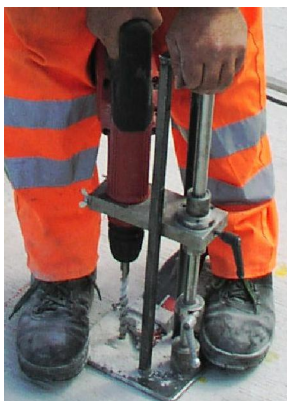
Bohrloch erstellen
