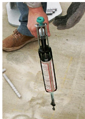
Verbundmasse einbringen
