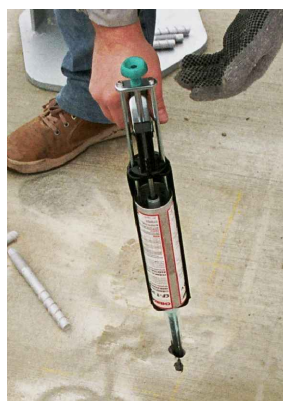
Verbundmasse einbringen
