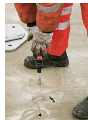
Betonschraube eindrehen
