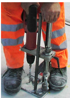
Bohrloch erstellen
