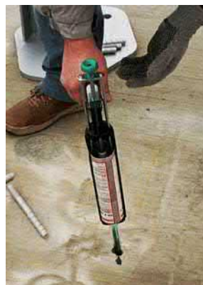
Verbundmasse einbringen
