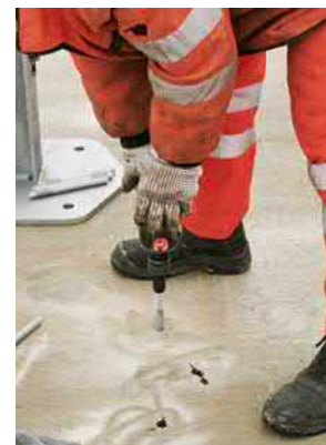
Betonschraube eindrehen
