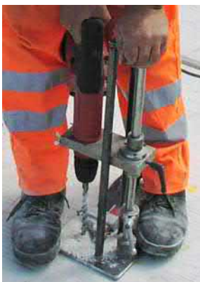
Bohrloch erstellen
