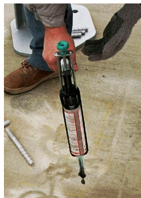
Verbundmasse einbringen
