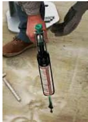
Verbundmasse einbringen
