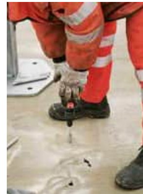
Betonschraube eindrehen
