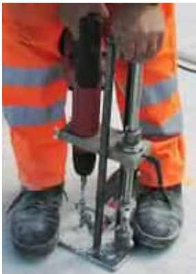
Bohrloch erstellen
