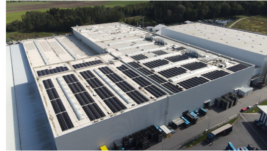
2,0 MWp, foil roof Solarwerk GmbH
