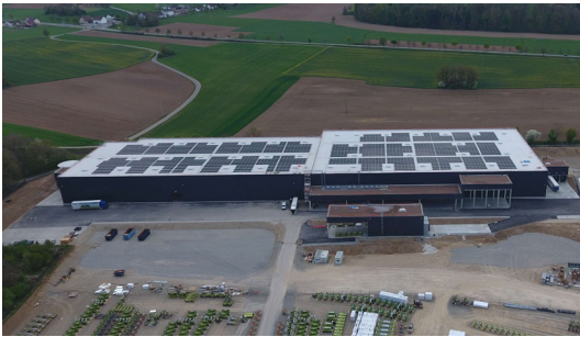
1,6 MWp, foil roof @ GOLDBECK GmbH
