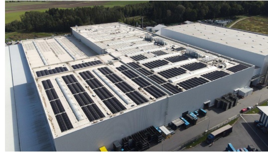
2,0 MWp, foil roof @Solarwerk GmbH
