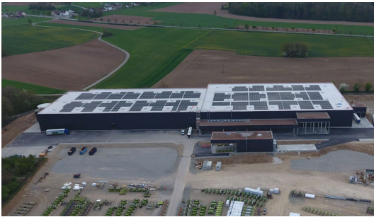
1,6 MWp, foil roof @ GOLDBECK GmbH
