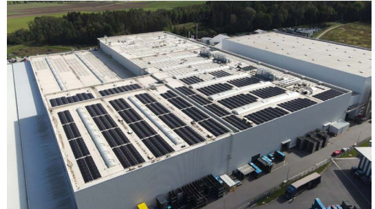
2,0 MWp, cubierta de lámina Solarwerk GmbH
