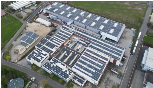
1,12 MWp, cubierta de lámina Benz AluSysteme
