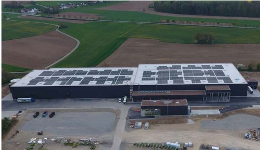
1,6 MWp, cubierta de lámina GOLDBECK GmbH
