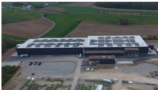
1,6 MWp, tetto in laminato GOLDBECK GmbH
