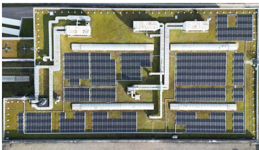
400 kWp, tetto verde Solarwerk GmbH
