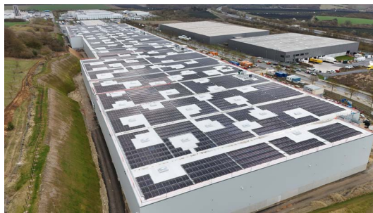
4,9 MWp, tetto in laminato DEE AG/ Greenflash GmbH
