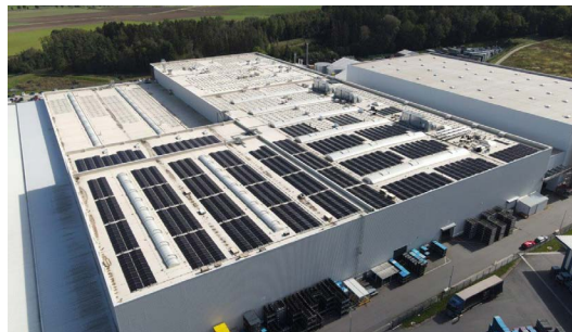
2,0 MWp, toiture plate Solarwerk GmbH
