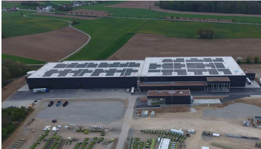
1,6 MWp, toiture plate GOLDBECK GmbH
