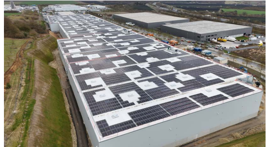
4,9 MWp, toiture plate DEE AG/ Greenflash GmbH
