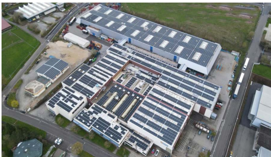
1,12 MWp, toiture plate Benz AluSysteme
