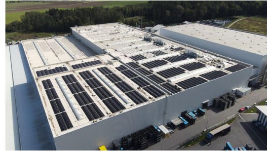
2,0 MWp, Foliendach Solarwerk GmbH
