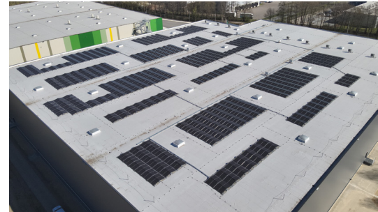
557 kWp, Foliendach SUNKON GmbH
