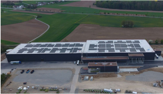
1,6 MWp, Foliendach GOLDBECK GmbH
