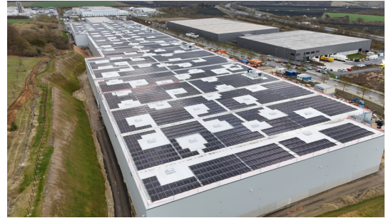
4,9 MWp, Foliendach DEE AG/Greenflash GmbH
