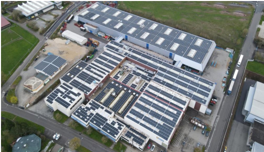
1,12 MWp, Foliendach Benz AluSysteme
