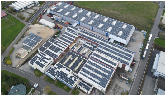
1,12 MWp, Foliendach @ Benz AluSysteme
