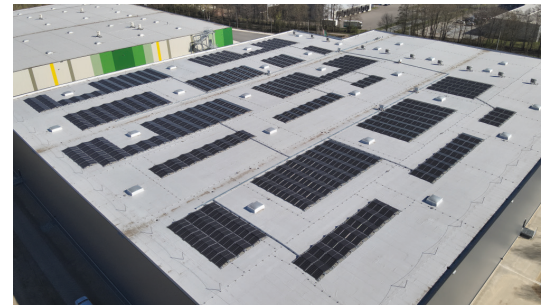
557 kWp, Foliendach @ SUNKON GmbH
