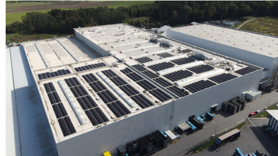
2,0 MWp, Foliendach @Solarwerk GmbH
