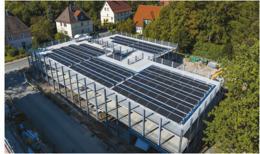
98 kWp, Betondach @ GOLDBECK GmbH
