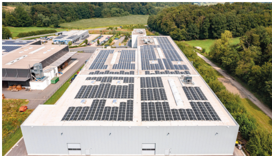
262 kWp, Erweiterung, Foliendach @ GOLDBECK GmbH
