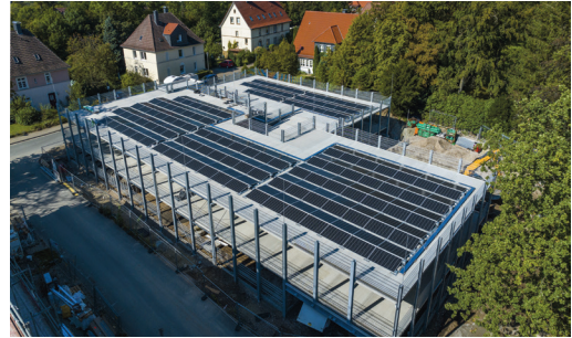
98 kWp, Betondach @ GOLDBECK GmbH
