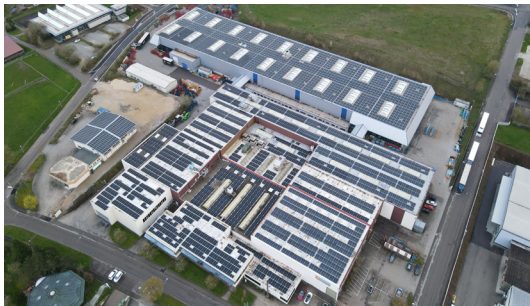
1,12 MWp, Foliendach @ Benz AluSysteme
