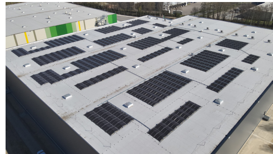
557 kWp, Foliendach @ SUNKON GmbH
