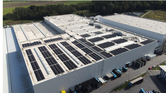
2,0 MWp, Foliendach @Solarwerk GmbH
