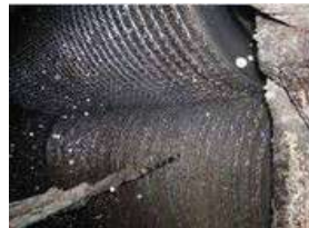
Aplicación de chapisco
