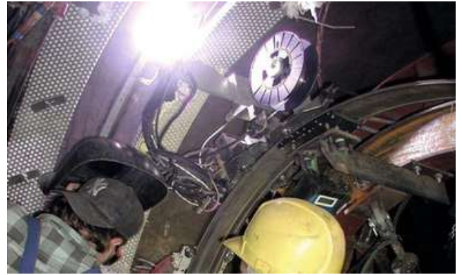
Compuerta Kaprun, Austria. El personal de MCE controla el proceso de alambre caliente GTAW totalmente mecanizado
