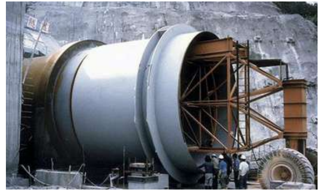
Prefabricación de la compuerta de Kaprun, Austria. Grado de acero S 690 Q, ASTM A514 Gr.F
