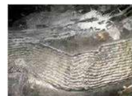
Reparación de fisuras en Molino de Bolas
