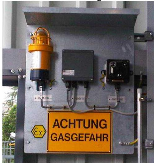
Wenn das Gaswarnpaneel in einer Ex-Zone eingesetzt wird, dann müssen alle Betriebsmittel (Hupe, Blitzleuchte, Klemmkasten mit Reihenklemmen, Kabel ATEX-konform sein. Das Paneel ist in den Potentialausgleich einzubinden. Ein Ex-Schild ist anzubringen. Erforderliche Gerätegruppe und Temperaturklasse beachten.
