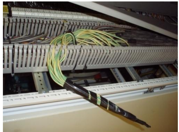
Abb. 21 - 24: Der ordnungsgemäße Fehlerschutz, sowie der Schutz vor gefährliche Berührungsspannung, garantiert durch die Durchgängigkeit des Schutzleiters, ist so nicht sichergestellt.
