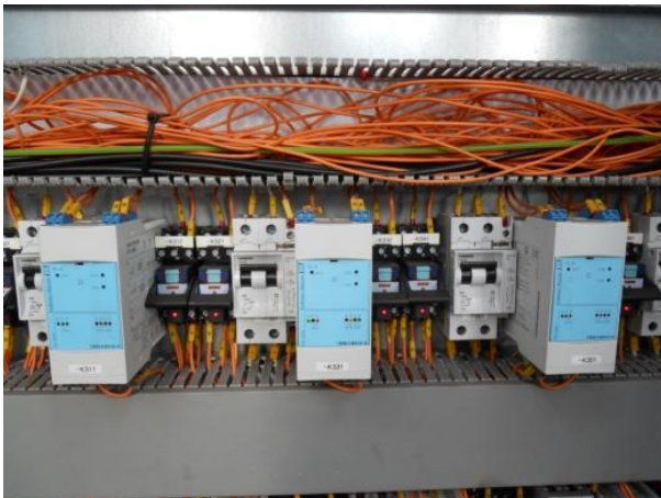
Abb. 53 - 54: Eigensicherheitsmodule nicht eigensicher verdrahtet. Keine getrennte Verlegung zu nichteigensicheren Kabel in den Installationskanälen.
