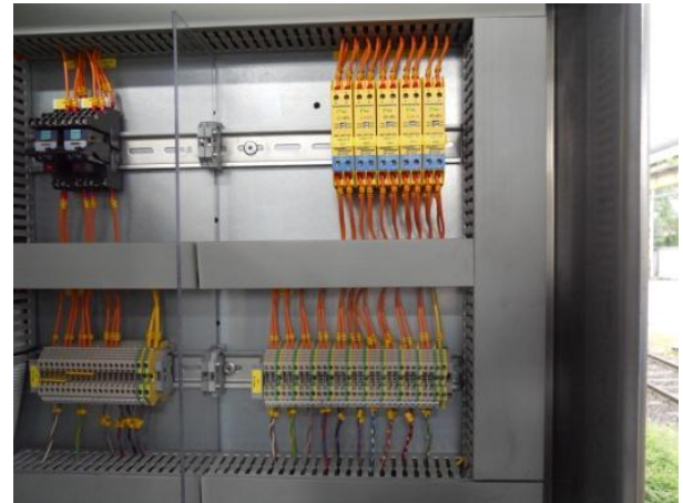
Abb. 53 - 54: Eigensicherheitsmodule nicht eigensicher verdrahtet. Keine getrennte Verlegung zu nichteigensicheren Kabel in den Installationskanälen.
