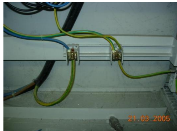
Abb. 10: Nullungsverbindungsleiter fehlt.
