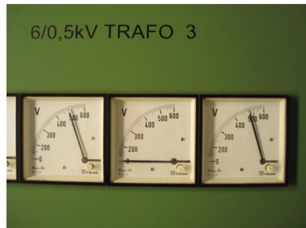
Abb. 27: Durch die Deaktivierung des Isolationsüberwachungsgerätes wird ein erster anstehender Erdschluss nicht erkannt.
