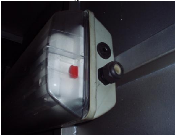
Abb. 49: Offene Verschlusschraube. Konstruktiver Zündschutz des
