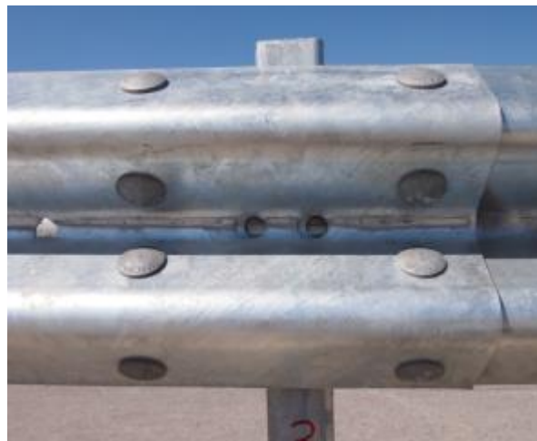
Obrázek 6: Sešroubování ve spoji
