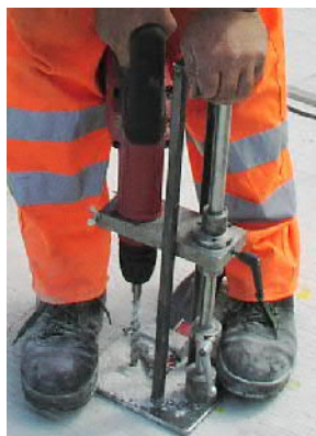
Bohrloch erstellen
