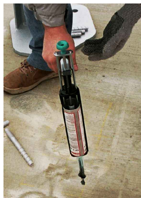
Verbundmasse einbringen
