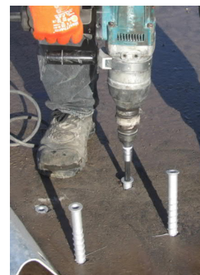
Privijanje asfaltnega vijaka
