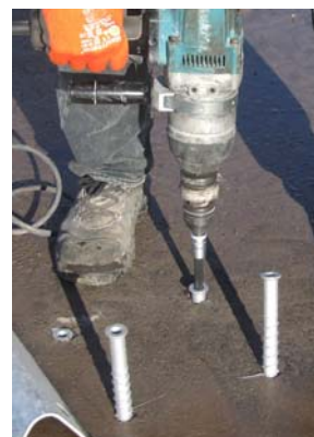
Vložte skrutku do asfaltu
