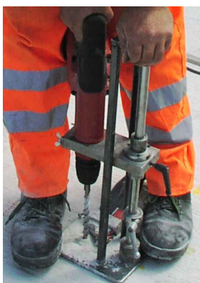
Bohrloch erstellen
