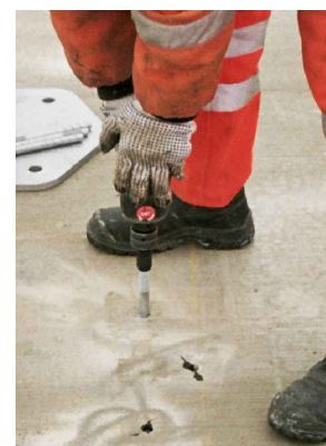
Betonschraube eindrehen
