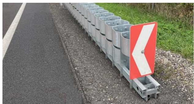
Abbildung 27: Ausrichtung Leitwinkel
