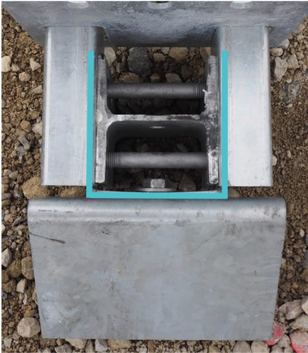
Abbildung 18: Montage am vorderen I120-Stehler mit Rampe
