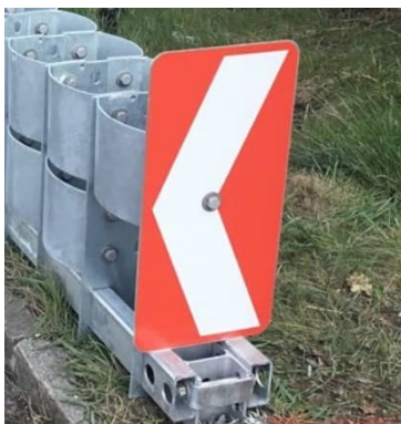
Abbildung 26: Verschraubung Leitwinkel
